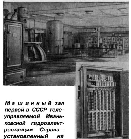
Маши́нный зал первой в СССР телеуправляемой Ивановской гидроэлектростанции. Справа — установленный на станции приемный релейный шкаф телеуправления
